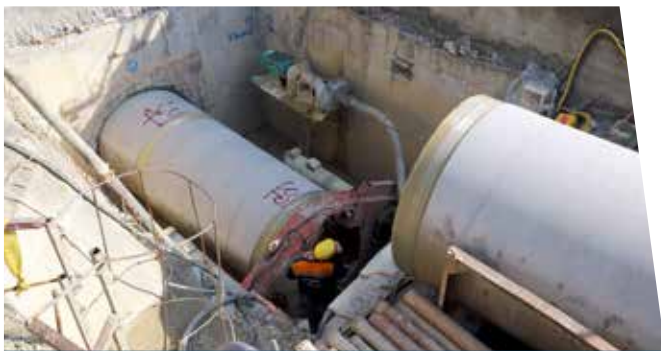
Укладка трубопровода канализации Ахваза и Каруна
