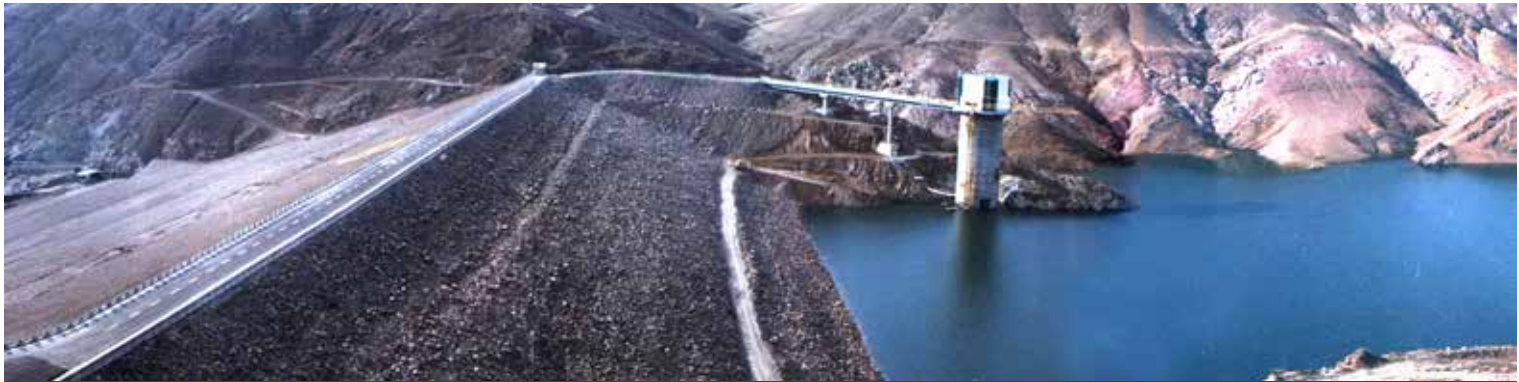
Земляная плотина Саттархан (Ахар) и сопутствующие сооружения
