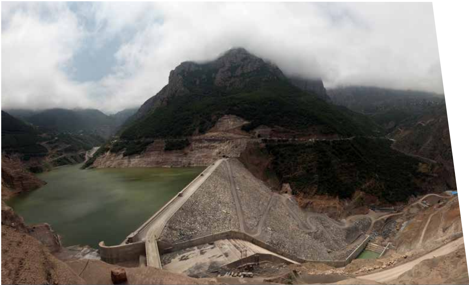
Верхняя и нижняя плотины и сопутствующие сооружения гидроаккумулирующей электростанции Сиях Бише
