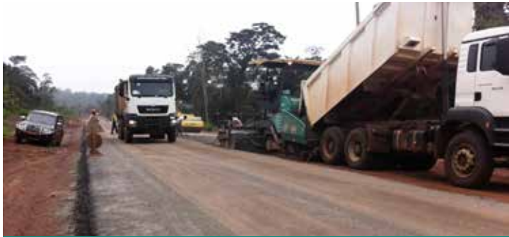
Дорога Сангмелима – Бикула. Камерун
