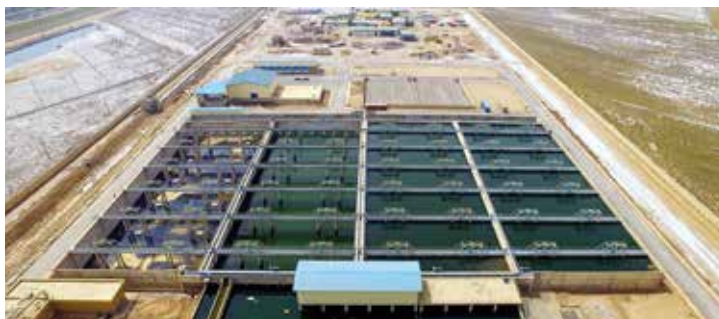
Водоочистные сооружения. Ахваз
