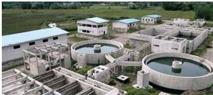
Водоочистная станция. Анзали
