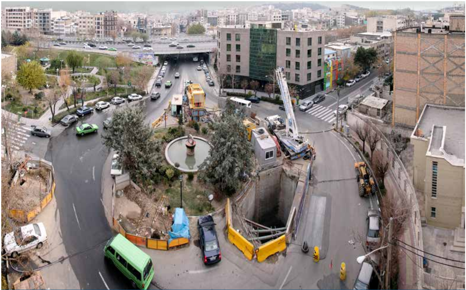
Трубопровод канализационной сети в Тегеране (район Шариати-Хадж Абдулла и районы 9-5-2)
