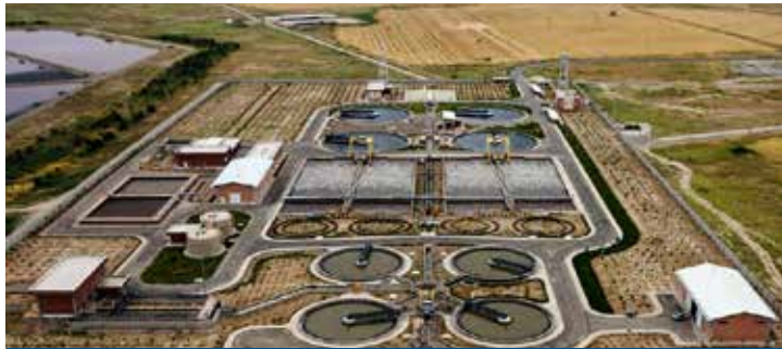
Станция очистки сточных вод Аль-Теймур. Мешхед
